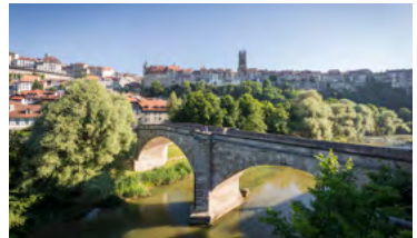
Pont de St-Jean Sankt-Johann-Brücke St. John's Bridge (1746)
