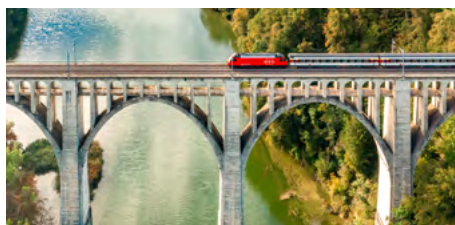
Viaduc de Grandfey Grandfey-Viadukt Grandfey-Viaduc 1862-1927
