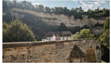
Pont du Milieu Mittlere Brücke Middle Bridge (1275, 1720)
