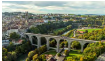
Pont de Zähringen Zähringerbrücke Zaehringen Bridge [1834, 1924]
