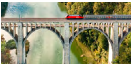
Viaduc de Grandfey Grandfey-Viadukt Grandfey-Viaduc
