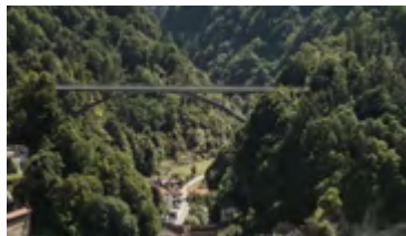
Pont du Gottéron Galtenbrücke Gottéron Bridge [1840, 1960]
